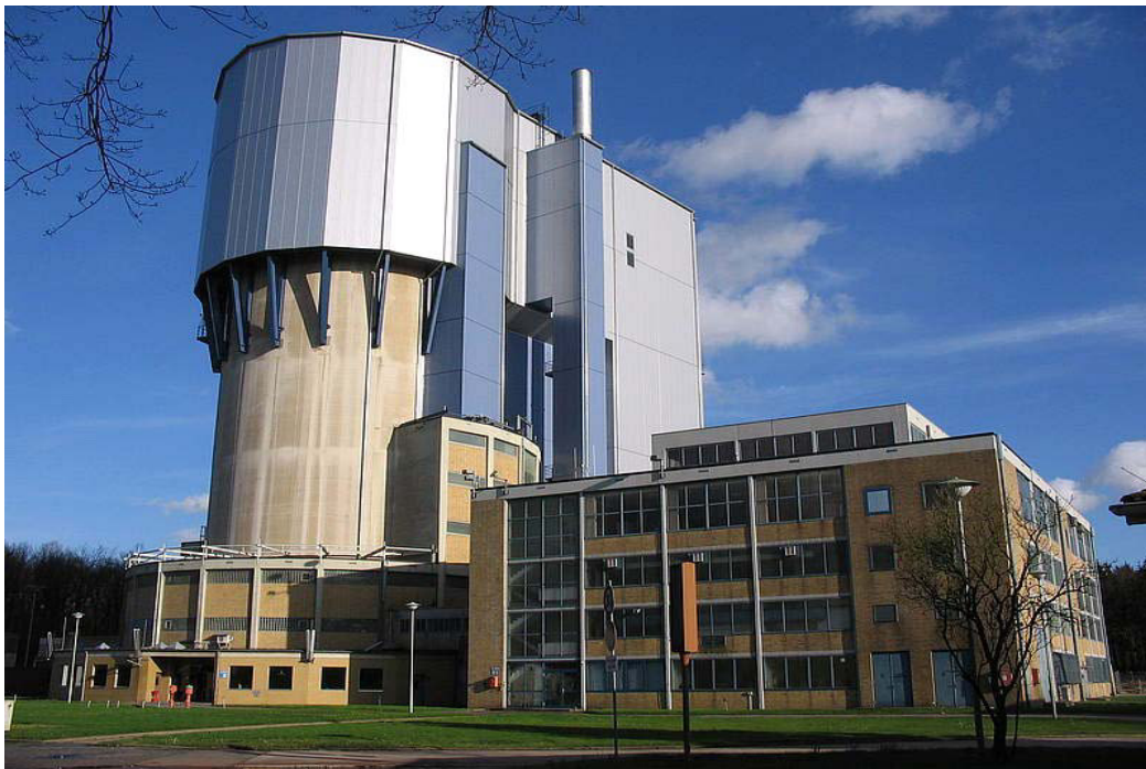
Abbildung D-17: Anbau der Materialschleuse an das Reaktorgebäude des AVR (Bildrechte: EWN)
