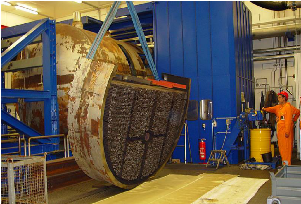
Abbildung D-16: Zerlegung eines Dampferzeugers durch Sägeverfahren im ZLN (Bildrechte: EWN)
