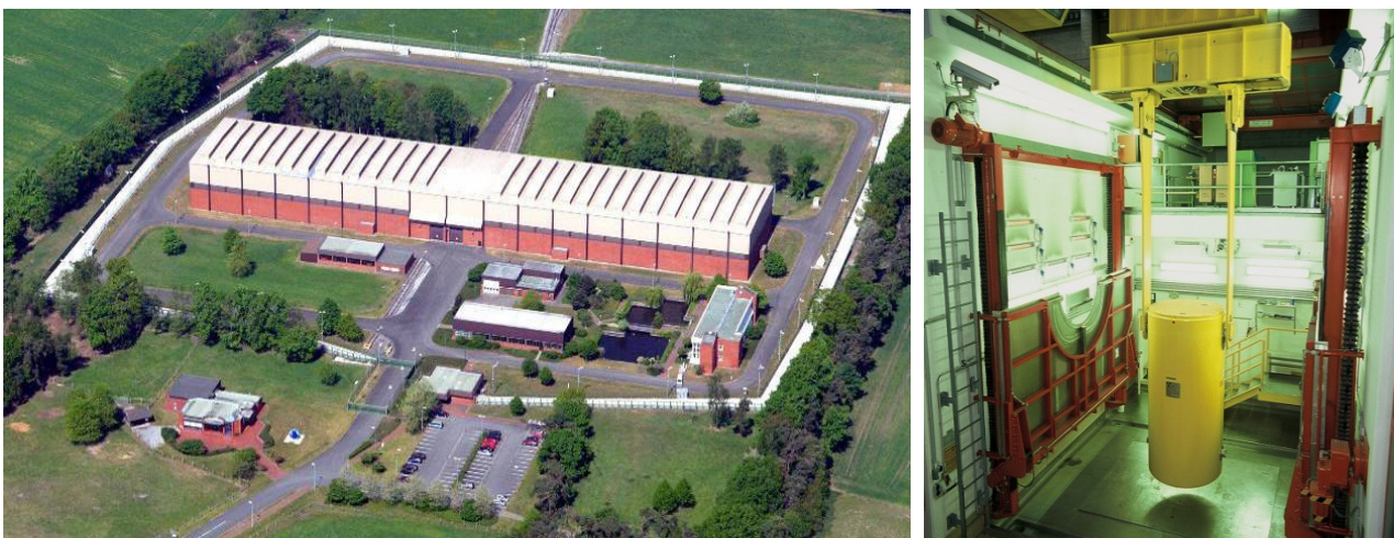
Abbildung G-2: Transportbehälterlager Ahaus (Bildrechte: GNS)
