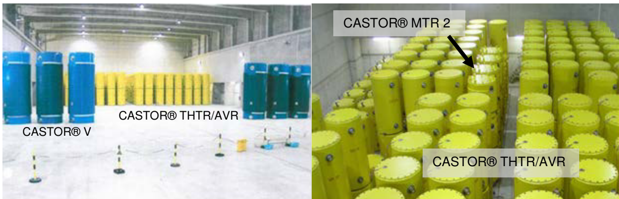
Abbildung D-5: Transportbehälterlager Ahaus (Bildrechte: GNS) links: CASTOR® V und CASTOR® THTR/AVR rechts: CASTOR® MTR 2 zwischen CASTOR® THTR/AVR
