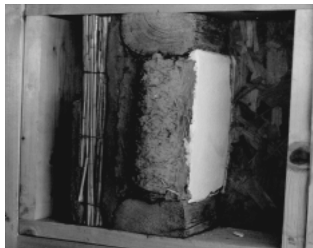
Abb. 1: Außenwandaufbau mit Edelputz, Lehm-Hack-schnitzel-Ausfachung, Holzleichtbauplatte, Schilfrohrmatte
