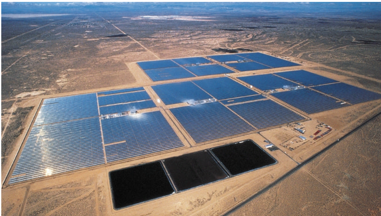
Abbildung 4–46: 5 x 30 MW-Parabolrinnen-Kraftwerke bei Kramer Junction in Kalifornien
