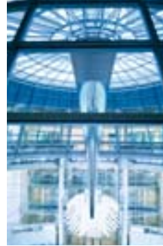
Der „Rüssel“ lenkt Licht in den Plenarsaal und transportiert Abluft ins Freie.
