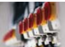
Rohrleitungen (oben) und Schalter. (unten)
