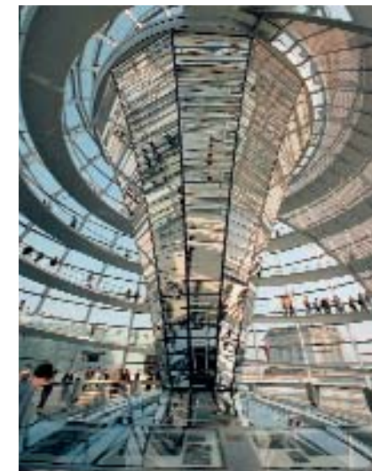
Der rüsselförmige Trichter lenkt Licht in den Plenarsaal.
