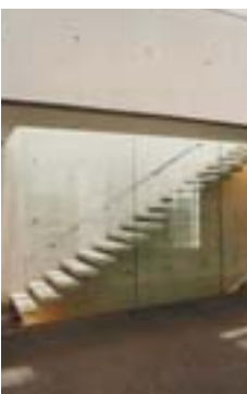
Detalle de una escalera del edificio Paul Löbe.
