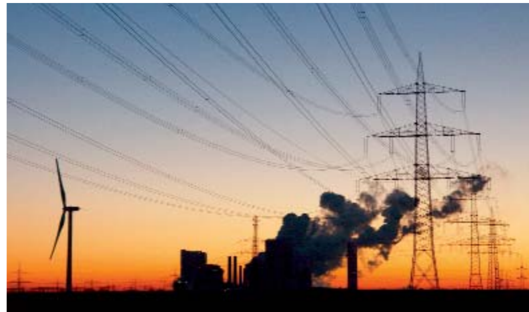
Windrad, Kraftwerk, Stromleitungen: Wie erzeugen wir künftig Energie?
