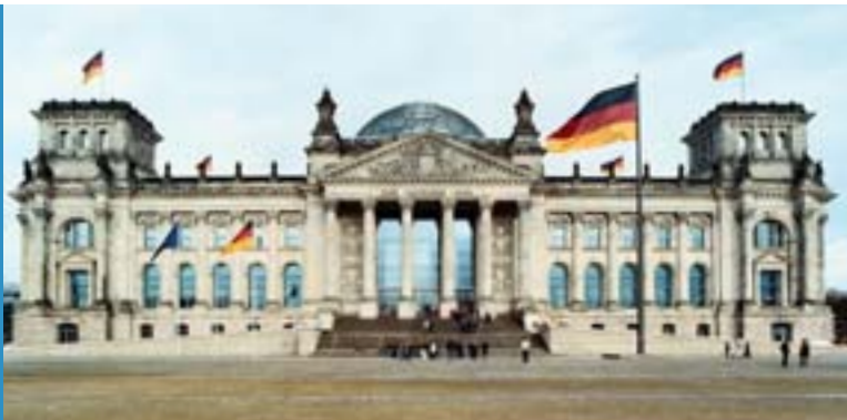
Blick auf das Reichstagsgebäude von Westen.
