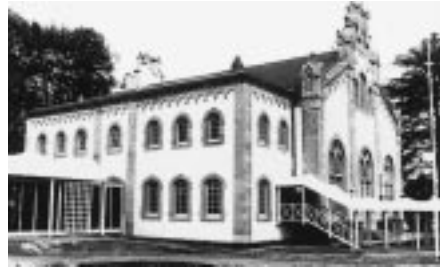
Zwischenstation »Wasserwerk« auf dem Gelände des Bundeshauses in Bonn.
