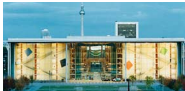
Vista del monumental frente acristalado desde el Oeste.
