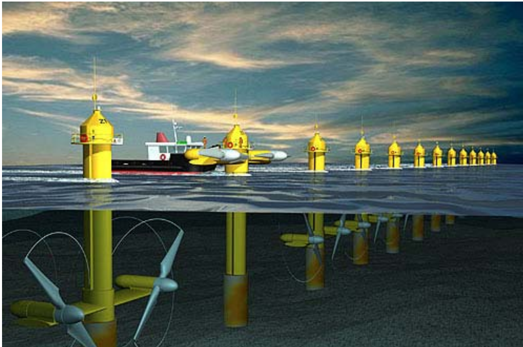
Abbildung 4: Mögliches Meeresströmungskraftwerk, bestehend aus einer Reihe von im Meeresgrund verankerten Turbinen-Masten. Ein Rotor-Paar ist zu Wartungszwecken über Wasser gehoben. [Quelle: Marine Current Turbines Ltd., http://www.marineturbines.com ]
