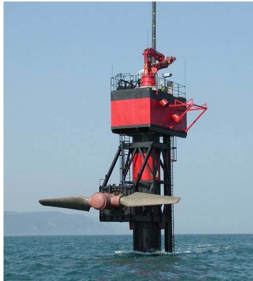
Abbildung 5: Foto der Strömungsturbine „Seaflow“ während einer Wartungsphase. Die Turbine mit einer Nennleistung von 300 kW ist seit 2003 bei Lynmouth, Devon (GB), 3 km vor der Küste in der Nordsee installiert. [Quelle: Marine Current Turbines Ltd. ]
