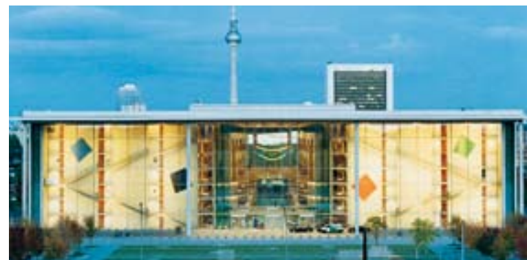
Widok od strony zachodniej na reprezentatywną szklaną stronę frontową.
