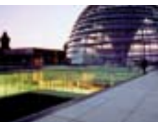
Kopuła nad poziomem frakcyjnym.
