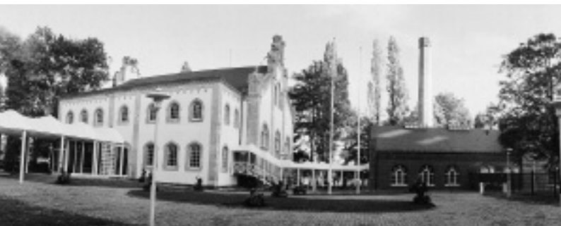
Ehemaliges Wasserwerk als Ausweichquartier des Plenarsaals · 1986
