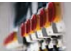
Rury i przełączniki.
