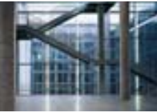
Die Haupthalle mit Büros (oben) und Treppenaufgängen. (unten)
