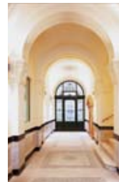
Bürotüren mit seitlichen Glasschlitzfenstern (oben) und der Eingangsbereich im Altbau Dorotheenstraße. (unten)
