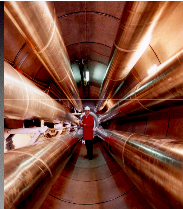
GIL-Erdverkabelung (Gasisolierte Leitung)
