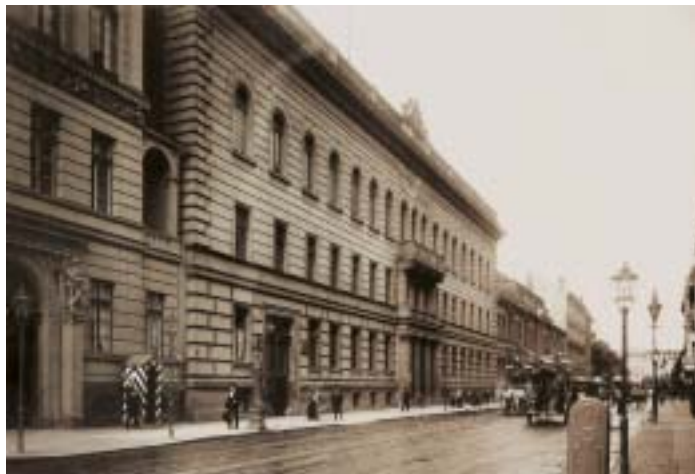
Das provisorische Reichstagsgebäude in der Leipziger Straße 4.
