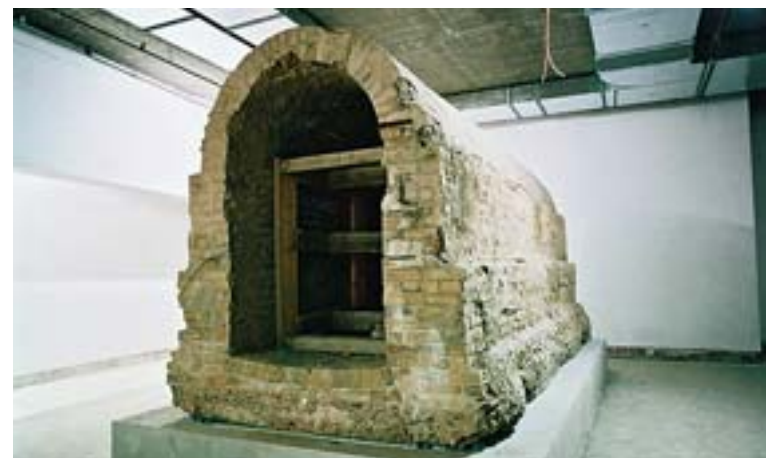
Tronçon du conduit de chauffage entre le bâtiment du Reichstag et l'ancien Palais du président du Reichstag.
