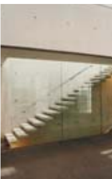
Escalier dans le bâtiment Paul-Löbe.
