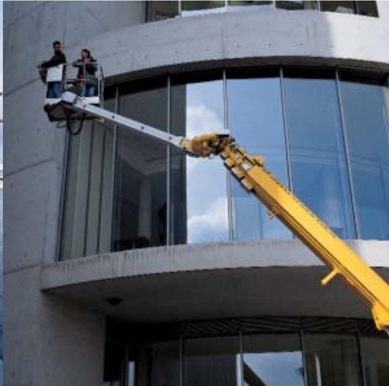
Arbeiten am Paul-Löbe-Haus.
