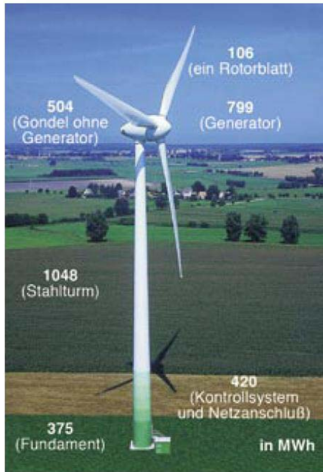
Abbildung 5: Energiebilanz der Herstellung eines Windrades: Die für die Produktion der einzelnen Anlagenteile benötigten Energiemengen sind in Megawattstunden (1 MWh = 1000 kWh) angegeben. (Quelle: Wagner 2004).
