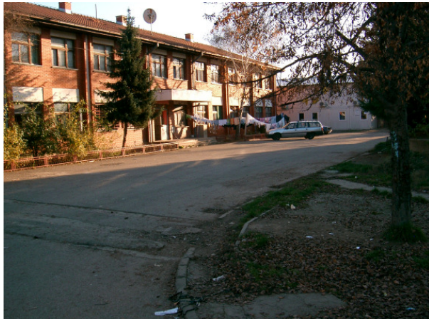
Wohngebäude im Camp Osterode
