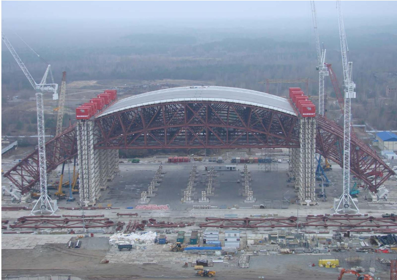
Abbildung 8: Ansicht (vom Sarkophag aus) nach erster Phase des Anhebens eines ersten Segments des New Safe Confinement (NSC)
