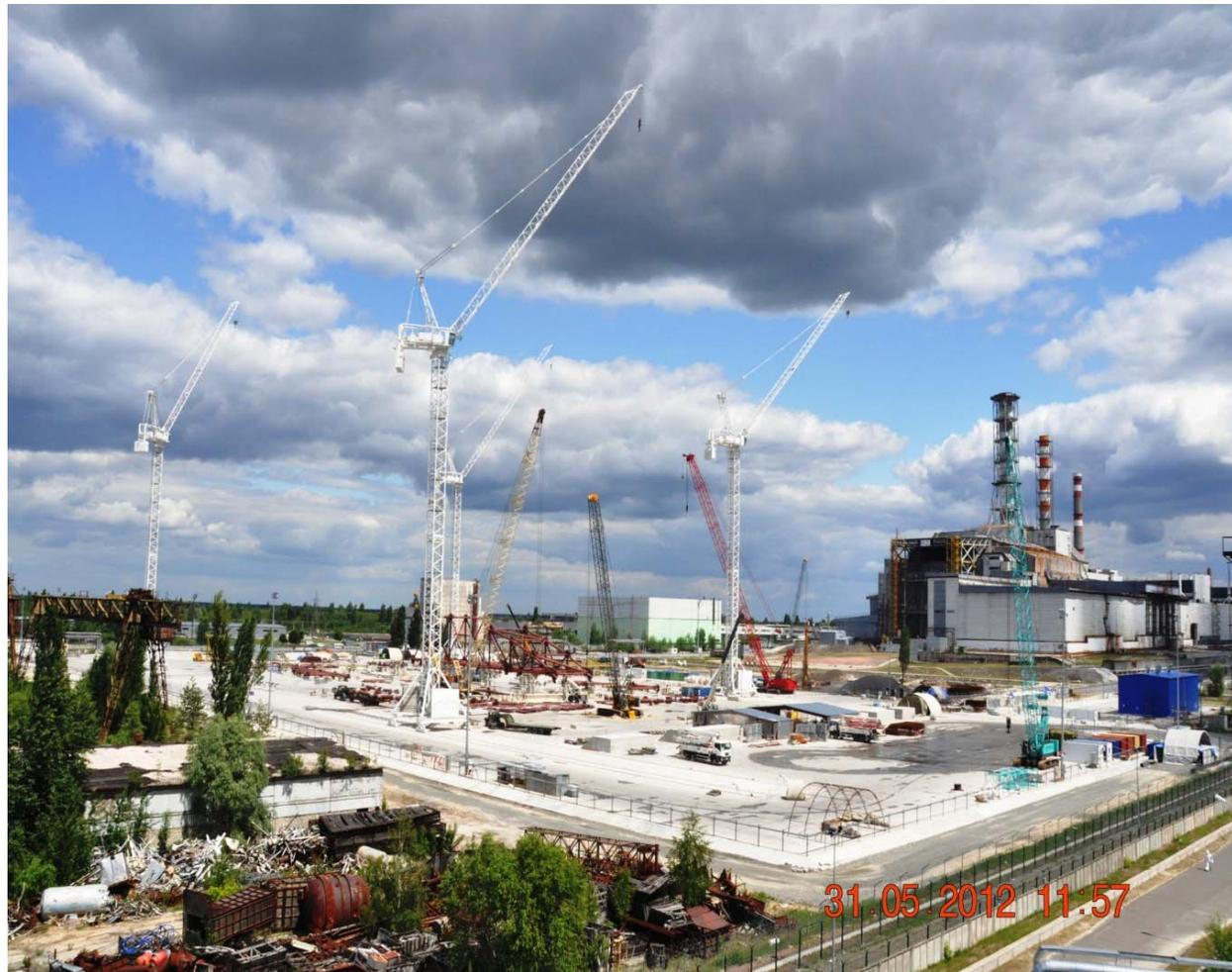
Abbildung 5: Fortgeschrittene Ansicht der vorbereiteten Errichtungsfläche für das New Safe Confinement (NSC) im Hintergrund ist in der Mitte der neue Abluftkamin für Block 4/3 zu sehen [Quelle: EBRD Präsentation 2012]
