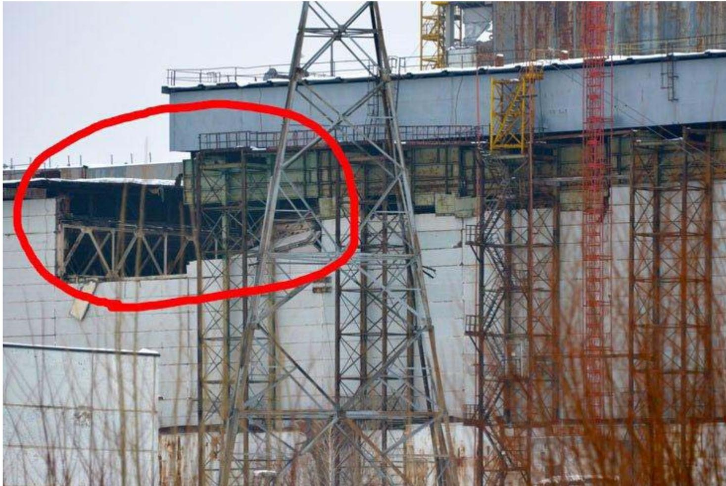
Abbildung 10: Einsturz eines Teils der Dachkonstruktion der Turbinenhalle [Quelle: ChnNPP, 12.02.2013 – 14:03 Uhr]
