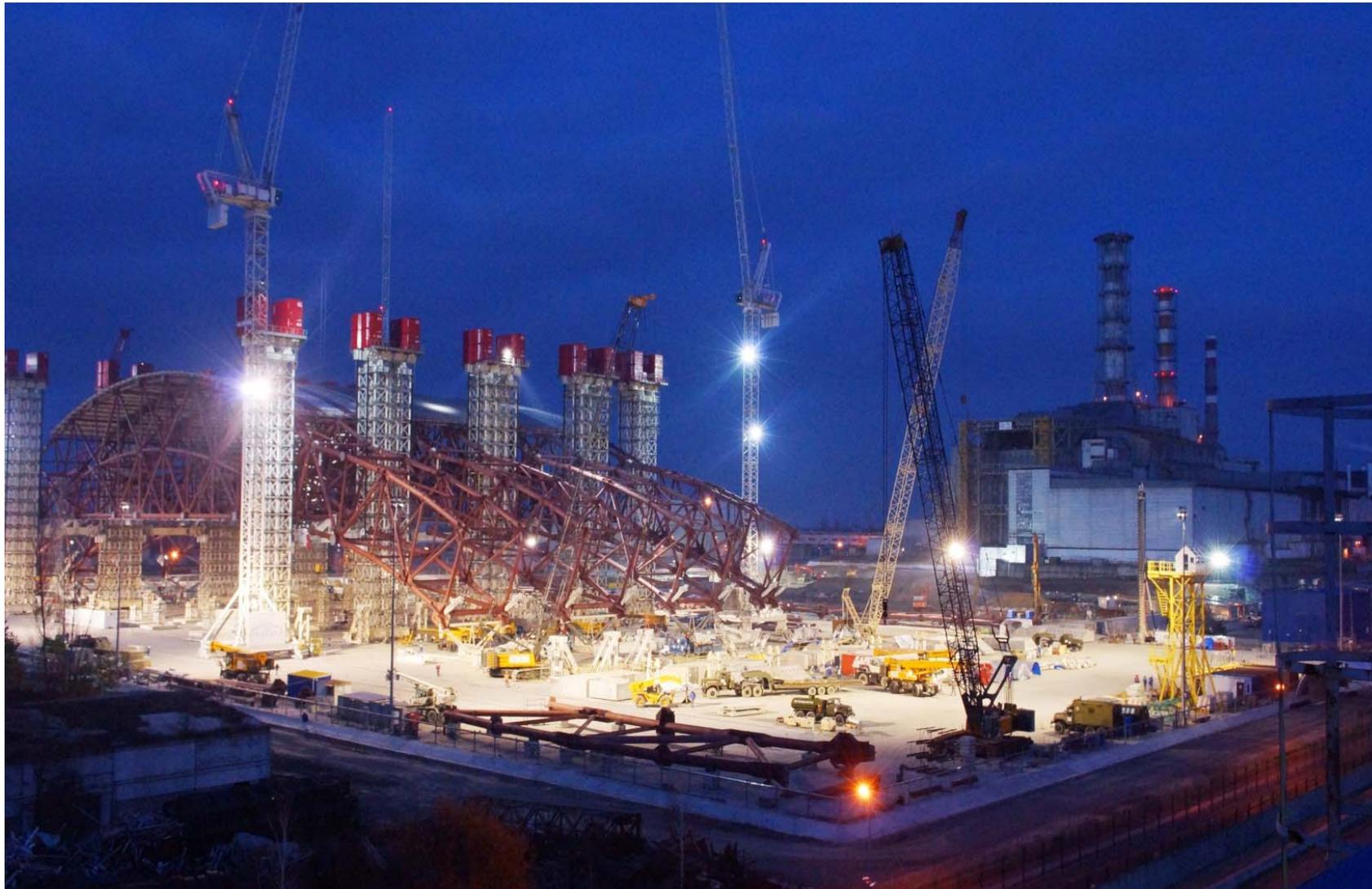
Abbildung 7: Anheben des ersten Segments des New Safe Confinement (NSC) bis zu einer Höhe von 22m über einen Zeitraum von 24 Stunden [Quelle: EBRD-Präsentation Dezember 2012]]
