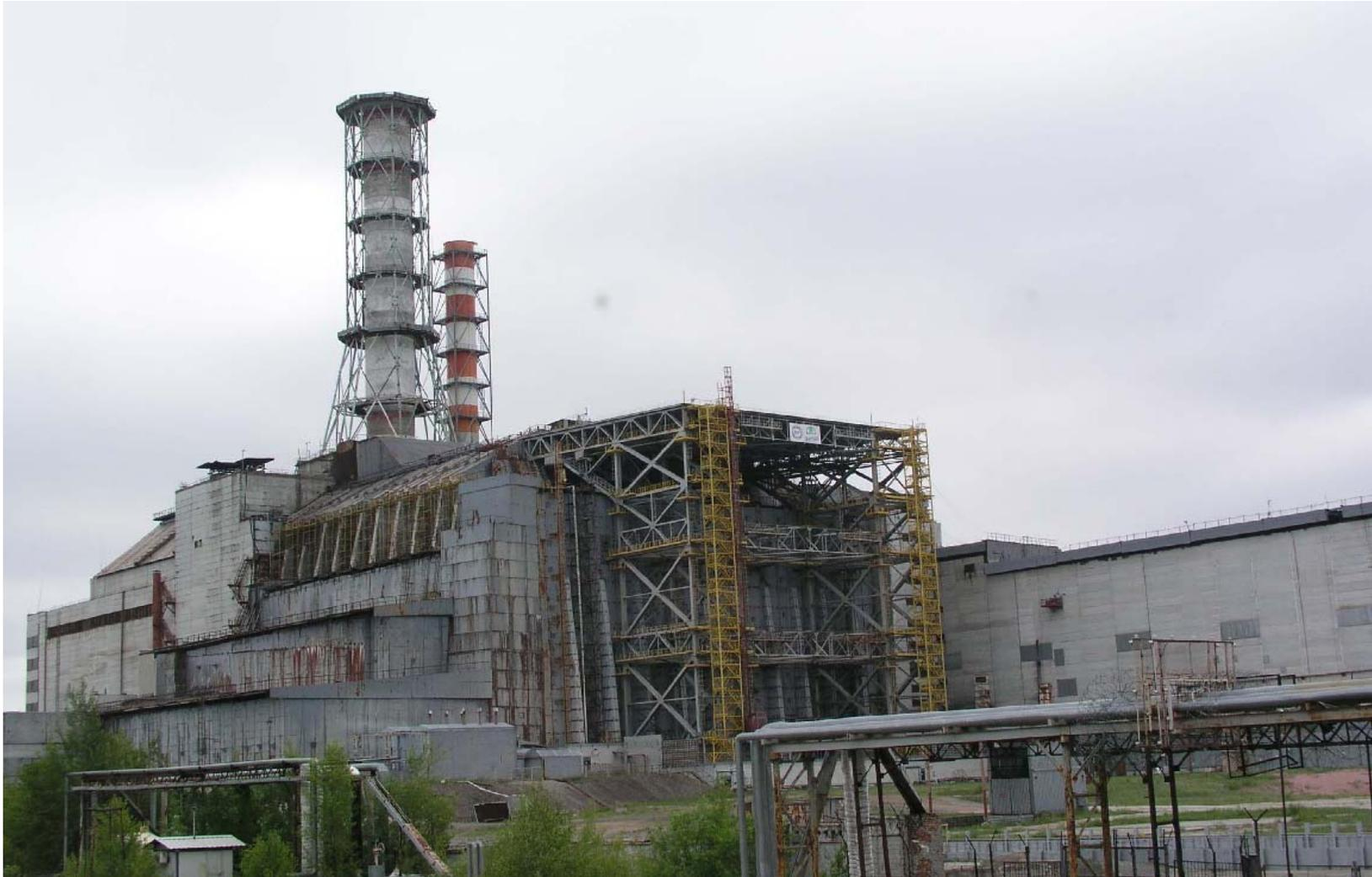
Abbildung 1: Sarkophag aus Sicht NW mit verstärkter Kaskadenwand (links), stabilisierter Westwand, altem und neuem Abluftkamin sowie Turbinenhalle (rechts) [Quelle: Foto BMU Mai 2012]
