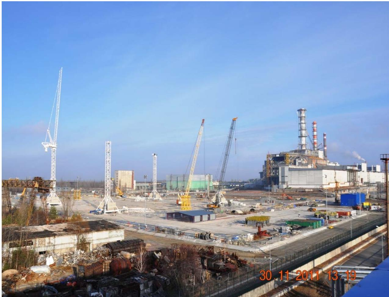
Abbildung 4: Ansicht der vorbereiteten Errichtungsfläche für das New Safe Confinement (NSC) im Hintergrund ist in der Mitte der neue Abluftkamin für Block 4/3 zu sehen [Quelle: EBRD Präsentation 2012]
