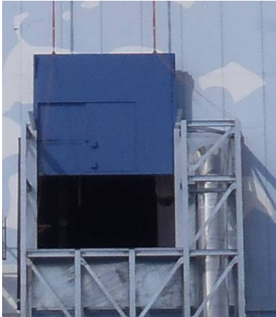
Abb. 10: Verschiessen der Druckentlastungsöffnung in Block 2
