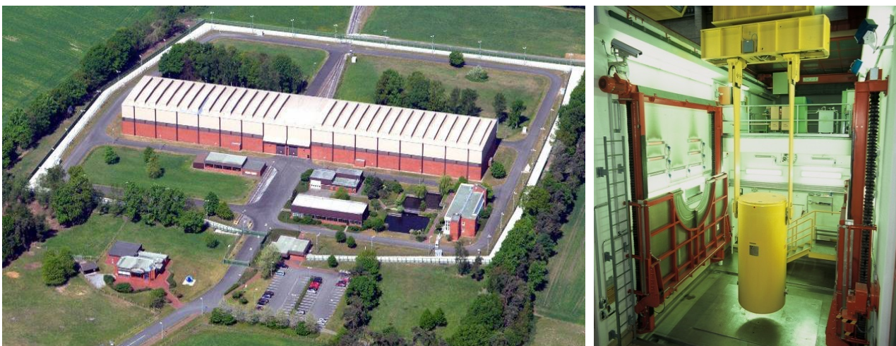
Abbildung G-2: Transportbehälterlager Ahaus (Bildrechte: GNS)
