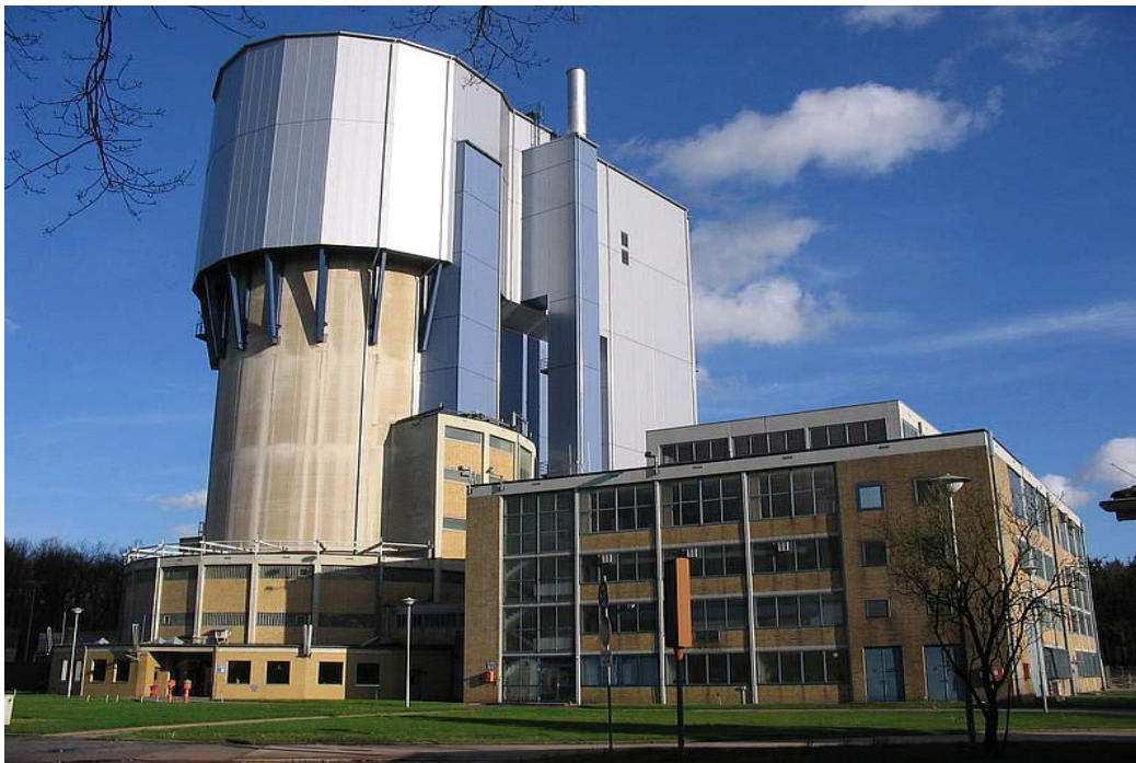
Abbildung D-17: Anbau der Materialschleuse an das Reaktorgebäude des AVR (Bildrechte: EWN)
