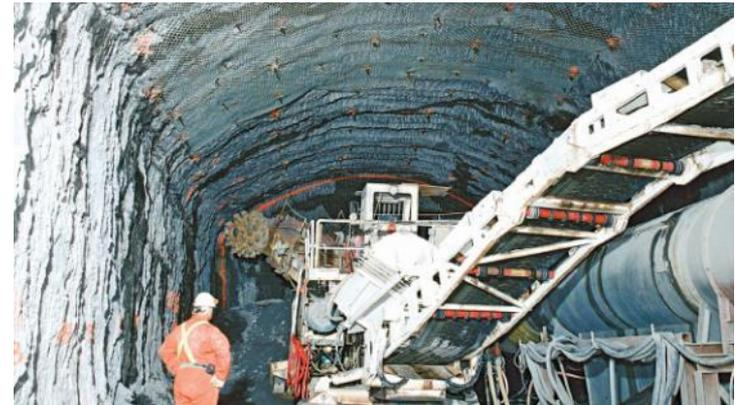
oben: Einlagerungstrecken: Anker-Spritzbetonausbau
