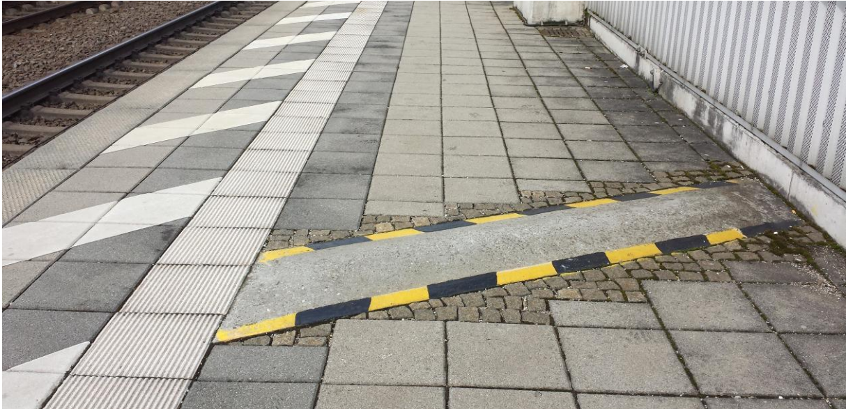
Abb. 10: Rollhemmender Belag und Ableit-Schwelle. Der rollhemmende Belag besteht aus 30 cm x 30 cm großen Betonplatten mit Fugen, eine spürbare Rollhemmung war nicht feststellbar. Die Betonschwelle mit rund 4 cm Höhe ist sanft abgerundet und zum Ende abgeflacht. Sie vermochte den Kinderwagen nur im flachsten Bereich aufzuhalten, auch erstreckt sie sich nur über 2 Meter Breite, auf 1,20 Meter Breite ist der Zulauf zum Gleis ungehindert. Diese „Stolperschwellen“ werden in Ingolstadt Nord schon ab einem Gefälle von 10 ‰ eingesetzt, für die Menschenströme im Großbahnhof Stuttgart 21 bspw. mit 15 ‰ Gefälle wären sie undenkbar.
