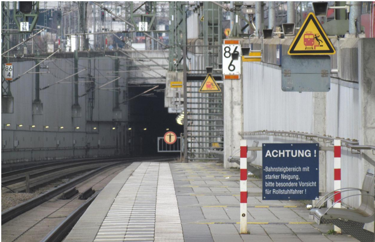
Abb. 9: Ortstermin in Ingolstadt Nord. Die Bahnsteige an Gleis 4 und 5 (hier) fallen in Richtung Audi-Tunnel immer steiler ab, am Beginn des gesicherten Bereiches mit 10 ‰ bis hin zu 20 ‰ Gefälle am Bahnsteigende. Ingolstadt Nord ist der steilste Regionalbahnhof in Deutschland.
