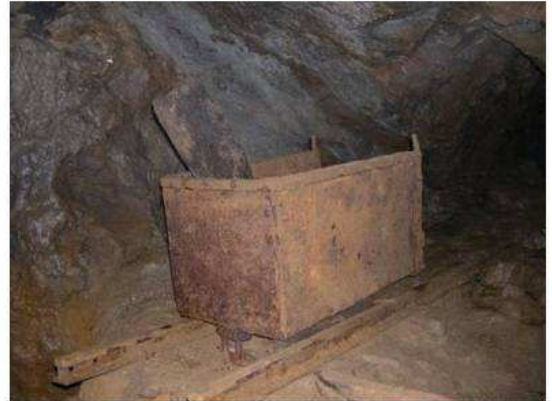
Korrozierender Behälter in einem Bergwerk
