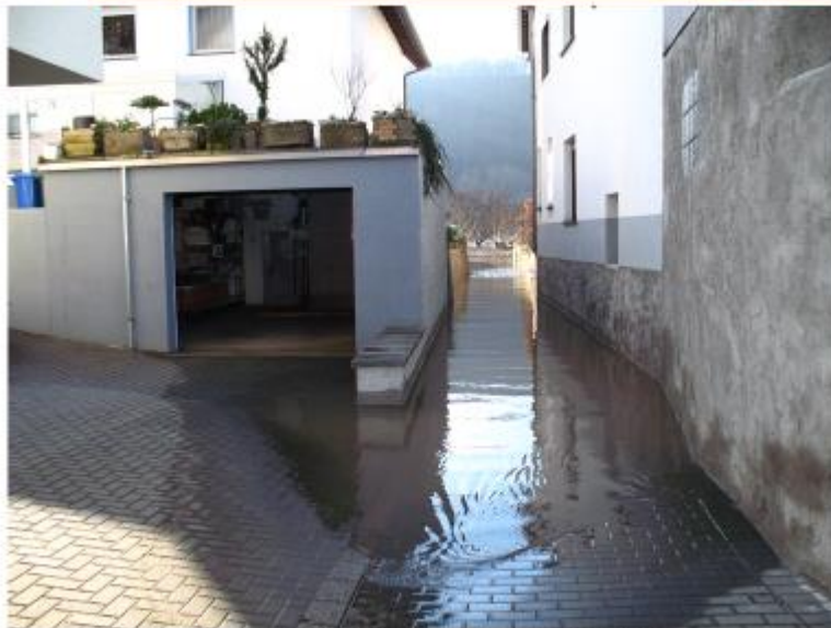
Kleines Hochwasser in Leutesdorf (Foto: Jüpner, 2011)
