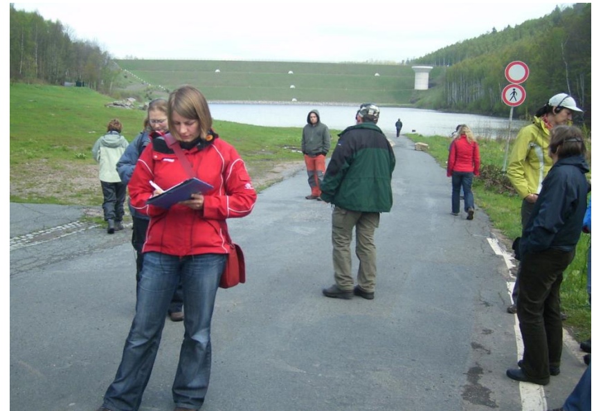
Fotos: Deltel Mahlo, Michael Bender Müglitz im Osterzgebirge Hochwasserrückhaltebecken in Lauenstein
