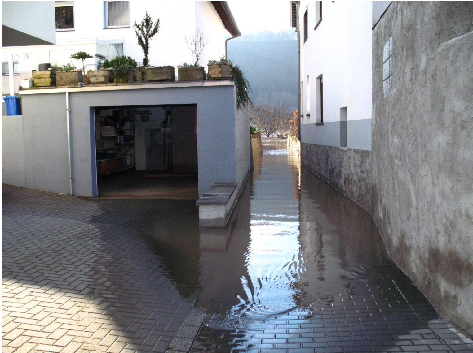
Kleines Hochwasser in Leutesdorf (Foto: Jüpner, 2011)
